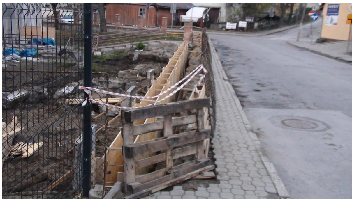
Fot. Budowa ogrodzenia i chodnika
