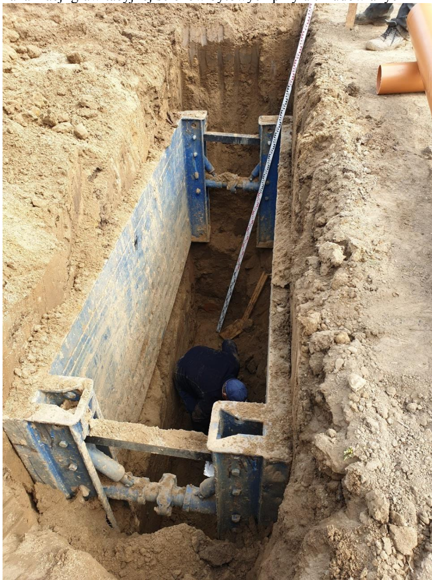
Fot. 20 Budowa kanalizacji grawitacyjnej ścieków bytowych przy ul. Budowlanych
