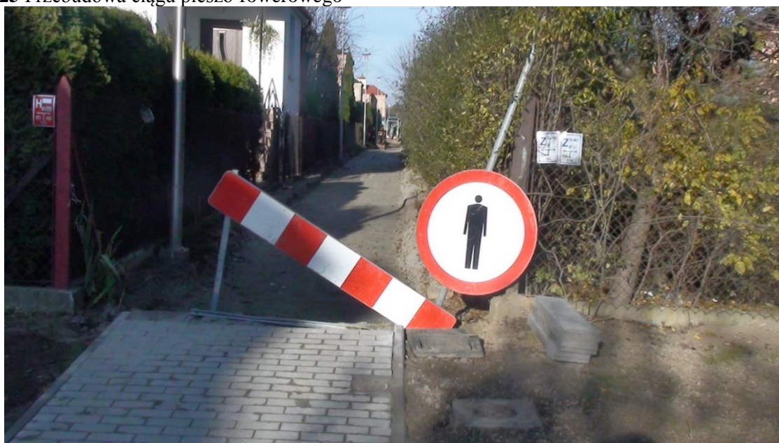
Fot. 25 Przebudowa ciągu pieszo-rowerowego
