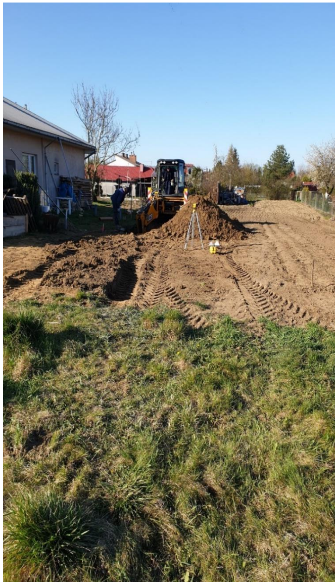
Fot. 21 Budowa kanalizacji grawitacyjnej ścieków bytowych przy ul. Zielonej
