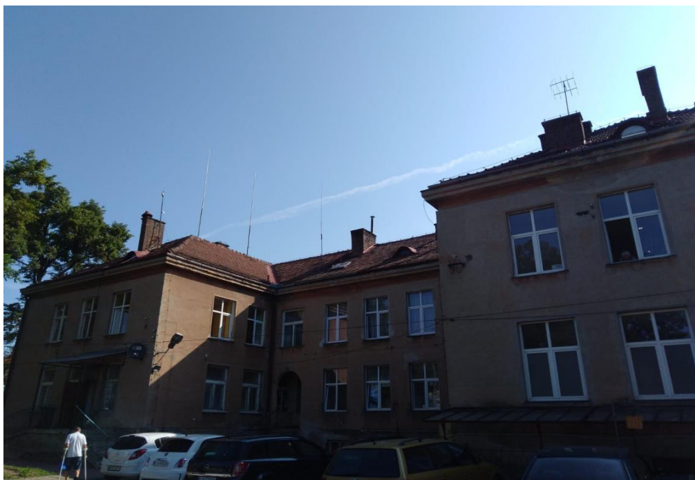
Fot. 12 Widok budynku ochrony zdrowia przed rozpoczęciem prac i w trakcie ich wykonywania.
