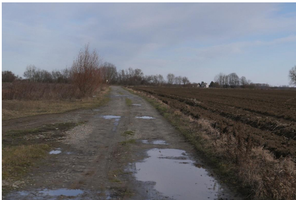
Fot. 15 Przedmiotowa droga przed realizacją
