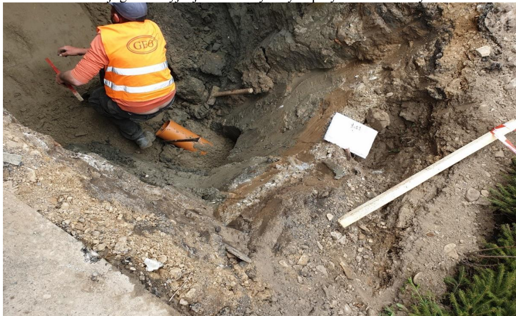
Fot. 19 Budowa kanalizacji grawitacyjnej ścieków bytowych przy ul. Budowlanych
