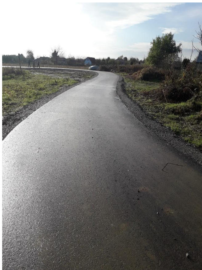
Fot. 16 Przedmiotowa droga po realizacji
